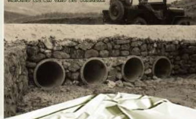
PONT RAIVER RÉALISÉ PAR LES HOMMES DE LA SAS DE TAZEMBA
