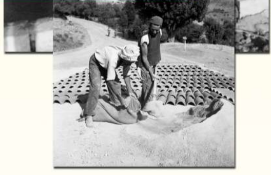
Captage de source et création d'un réservoir d'eau. Mise en route du four à tuiles, Fonds TRIBALLIER, CDHA
